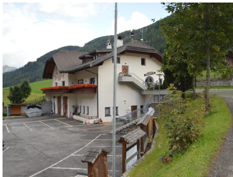
Das Haus der Vereine - seit 1990 Heimat für die verschiedenen Vereine: Schützenstübli, Proberaum für Chor und Musikkapelle, Feuerwehrzentrale, Arzt-raum, Jugendraum, großer Saal mit kleiner Küche und Hausmeisterwohnung.
